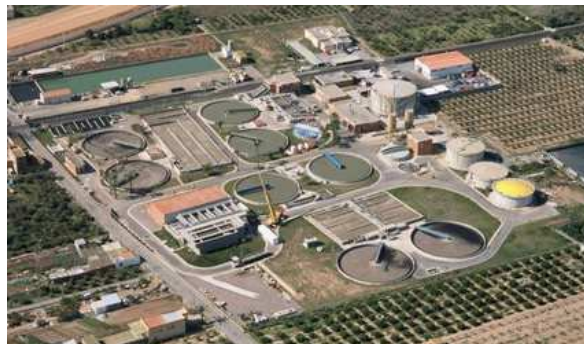
EDAR de Castellón Fuente: EPSAR
